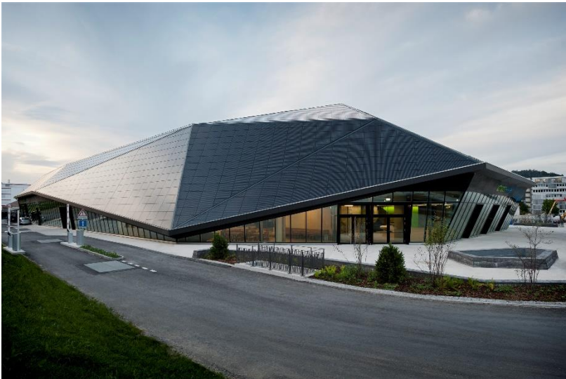
Figura: Umwelt Arena Spreitenbach
